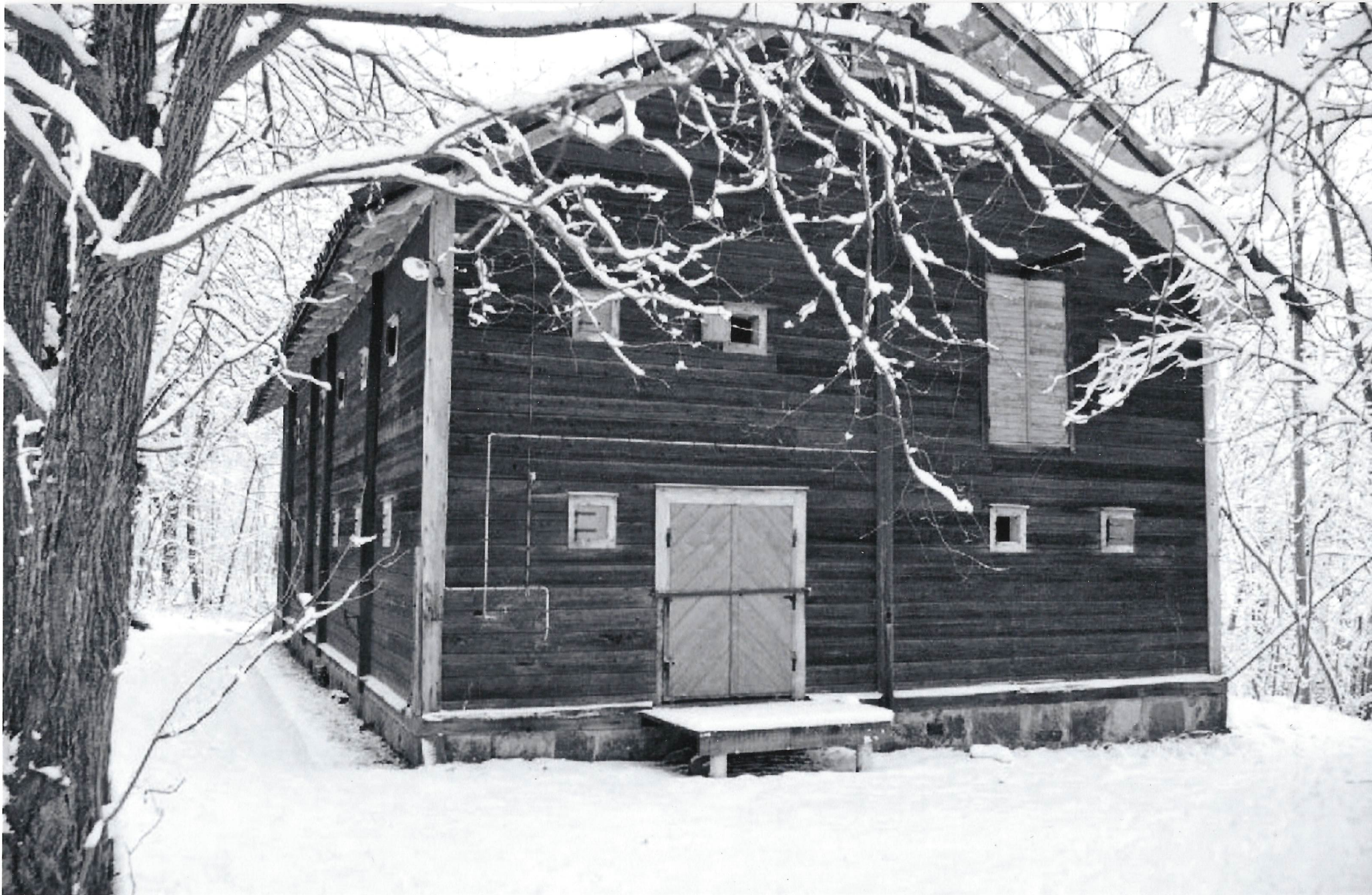
Kruthuset vid Mjöldammen Foto: Britt-Marie Bredberg, 2004
